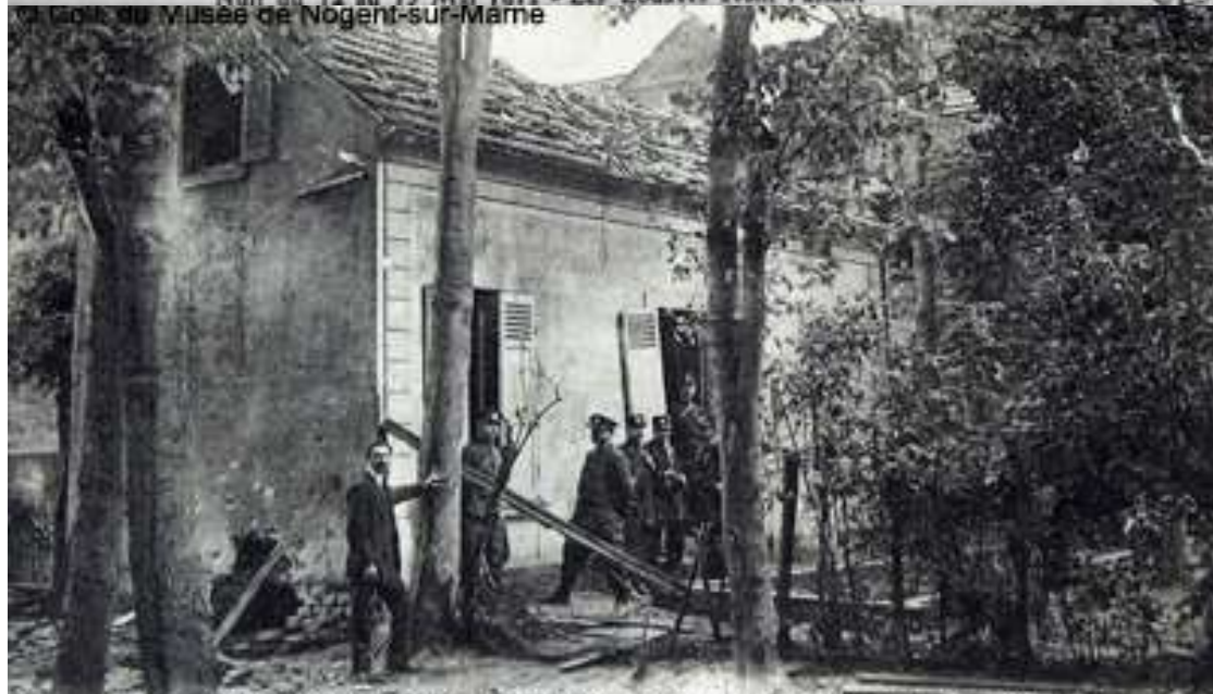
Après la tragédie de NOGENT-SUR-MARNE — Côté de la maison où se trouve l'excavation faite par la dynamite (Photographie prise le 22 mai 1912)
