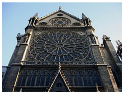
La façade du croisillon nord du transept avec la rosace nord.
