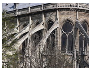
Les grands arcs-boutants du chevet de Notre-Dame furent lancés par Jean Ravy et ont une portée de 15 mètres.
