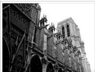
Les grands arcs-boutants avec leurs culées massives et leurs longues gargouilles, au niveau de la façade nord de la nef.
