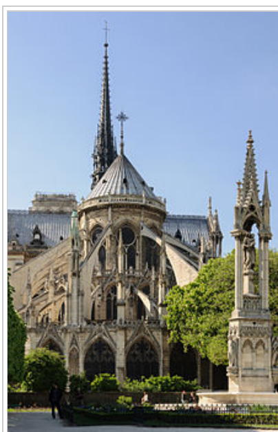
Vue du chevet de la cathédrale et de ses trois niveaux de fenêtres. Les fenêtres des chapelles rayonnantes comme celles des tribunes sont surmontées d'un gable. Il en va de même de la partie inférieure des culées des grands arcs-boutants. Une frise de billettes court sous la balustrade supérieure.
