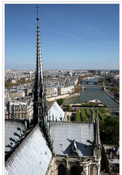
Vue de la flèche et des toits de Notre-Dame, prise depuis le sommet de la tour sud en direction de l'est.
