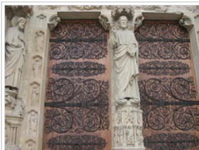
Les pentures du portail du Jugement réalisées par Boulanger (xix e siècle).
