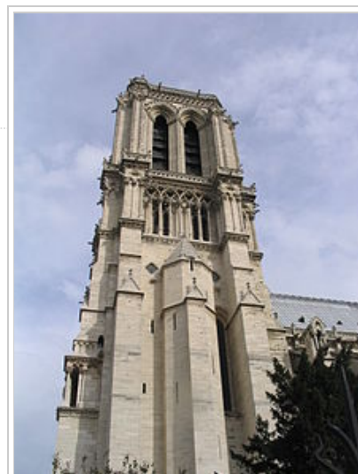
La moitié inférieure de la face sud de la tour sud, fort peu ornée, a des allures austères de forteresse. Cette partie de la tour est flanquée d'une tourelle polygonale percée de meurtrières et abritant un escalier permettant l'accès aux étages supérieurs. La base des tours date des années 1190-1225, c'est-à-dire du règne de Philippe Auguste.
