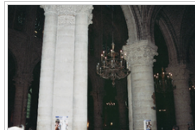
Vue des trois premières colonnes bordant la nef au sud (droite). La troisième (à droite sur la photo) est parfaitement cylindrique, la seconde (au centre) comporte une colonne engagée, la première (à gauche) en comporte quatre et répond de ce fait au modèle de la cathédrale de Chartres.
