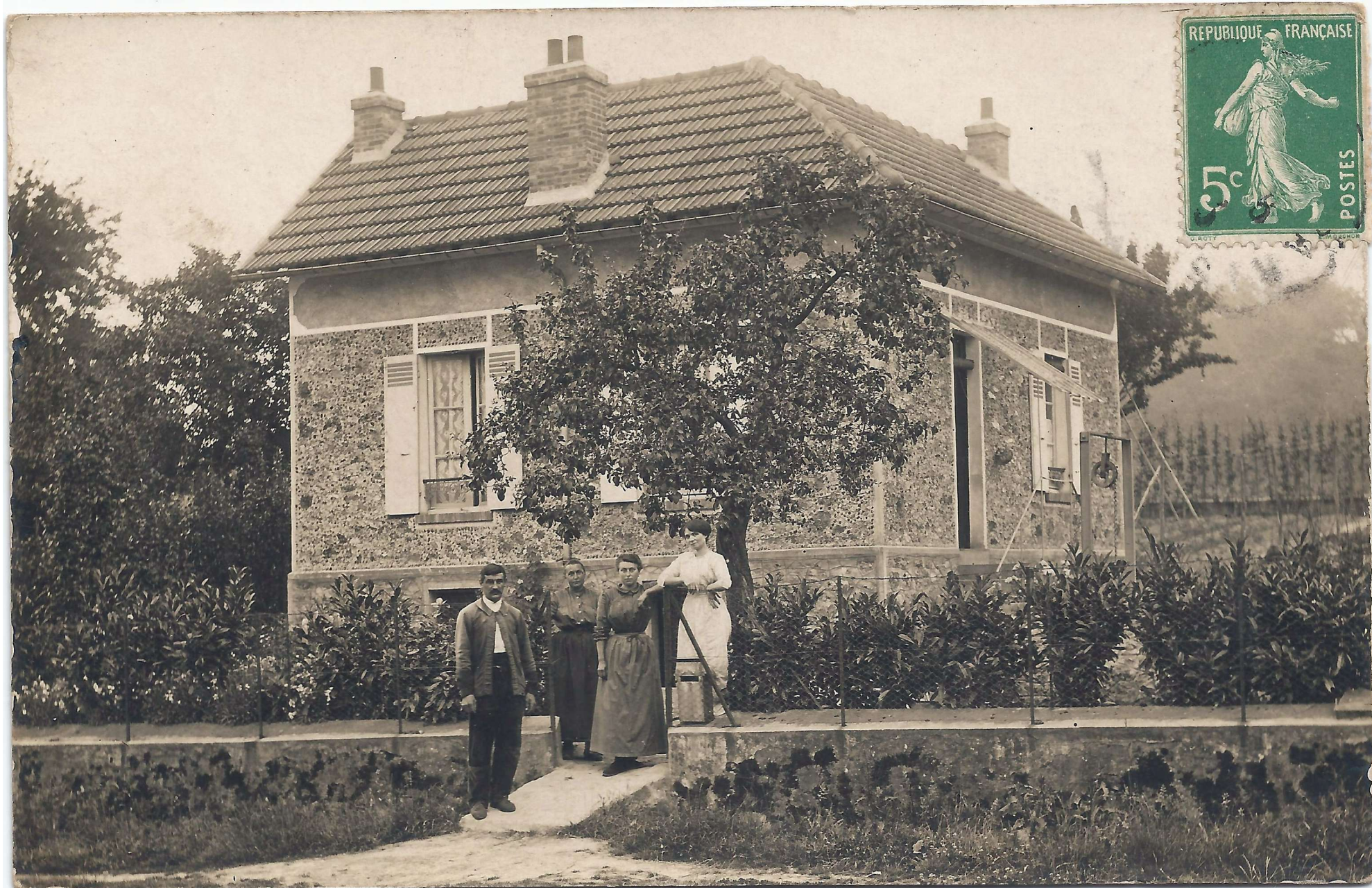
En 1910, Ernest et Adeline ont fait construire cette maison près de la route de Chartres
